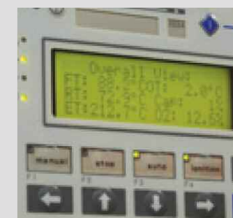
Mae monitro tymheredd dŵr a gollyngiadau simnai yn gyson yn sicrhau bod y system yn gweithio mor effeithlon â phosib.
