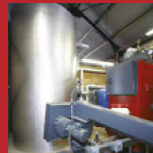
Bwyler Binder cwbl awtomatig a thanc cronni cyfaint uchel.
